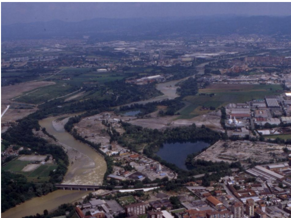
Figura 3. Il Torrente Stura di Lanzo al suo ingresso in Torino: sulla sinistra il rilevato della discarica RSU di Torino ed a destra le aree fra l'abitato e la sponda destra orografica oggetto di bonifica d'interesse nazionale del Ministero dell'Ambiente con la presenza di una fascia di attività improprie sulla sponda
